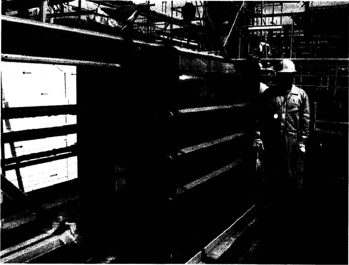
Figura 2. Intercambiador de calor de placas y marco. Fuente: Propio.
