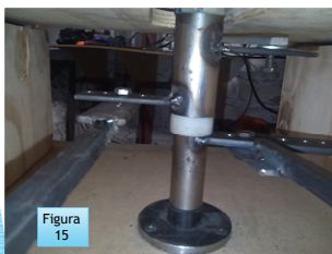
Figura 15. Montaje del Sistema poste central con fundas sobre la base del primer modelo de pruebas, construido con soportes de madera.
